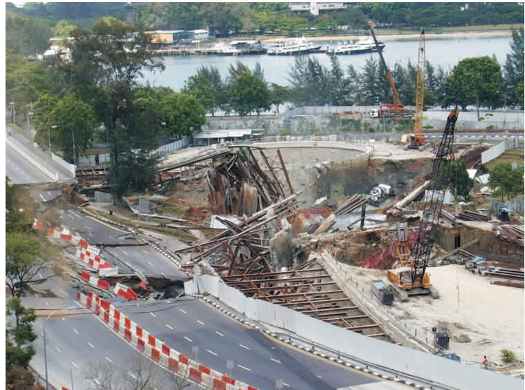
Abbildung 5.15: Schnitt durch die Baugrube unmittelbar vor dem Kollaps und Bild der eingestürzten Baugrube am 20. April 2004
